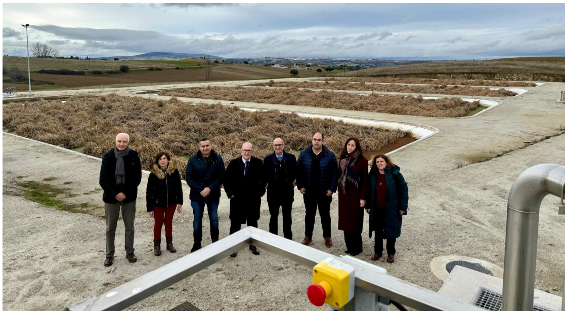
Nueva depuradora de Cespedosa de Tormes (Salamanca)Jcyl
